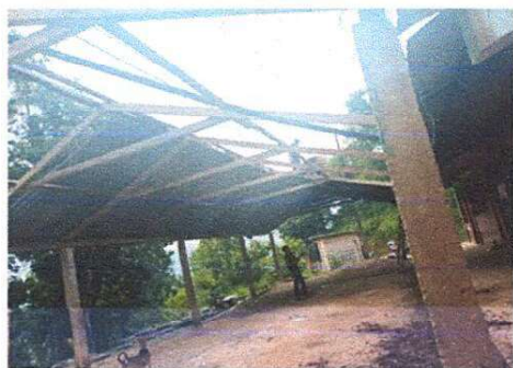
Foto1: DESMONTAJE DE LAS LÁMINAS ACANALADAS Y DE LA ESTRUCTURA DEL TECHO DE MADERA
