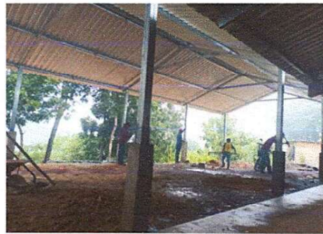
Foto 2: APLANAMIENTO DEL SUELO PARA TIRAR LA TORTA DE CEMENTO
