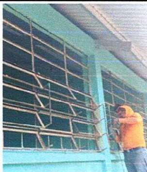
Foto1: LIMPIEZA DE BALCONES
