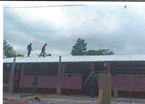
Foto 4: COLOCACIÓN DE LÁMINAS TROQUELADAS Y CAPOTES
