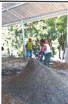
Foto 5: PREPARACIÓN DE MEZCLA PARA TORTA DE CEMENTO
