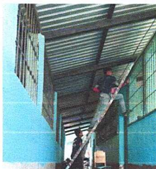
Foto 2: PINTURA DE PAREDES DEL EXTERIOR
