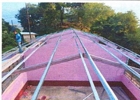
Foto 3: COLOCACIÓN DE LA ESTRUCTURA METÁLICA
