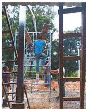
Foto 3: COLOCACIÓN DE COSTANERAS Y TIJERAS PARA TECHO DEL SALÓN
