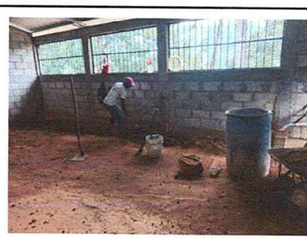
Foto 6: APLANAMIENTO Y PREPARACIÓN DEL SUELO PARA TORTA DE CEMENTO EN EL AULA
